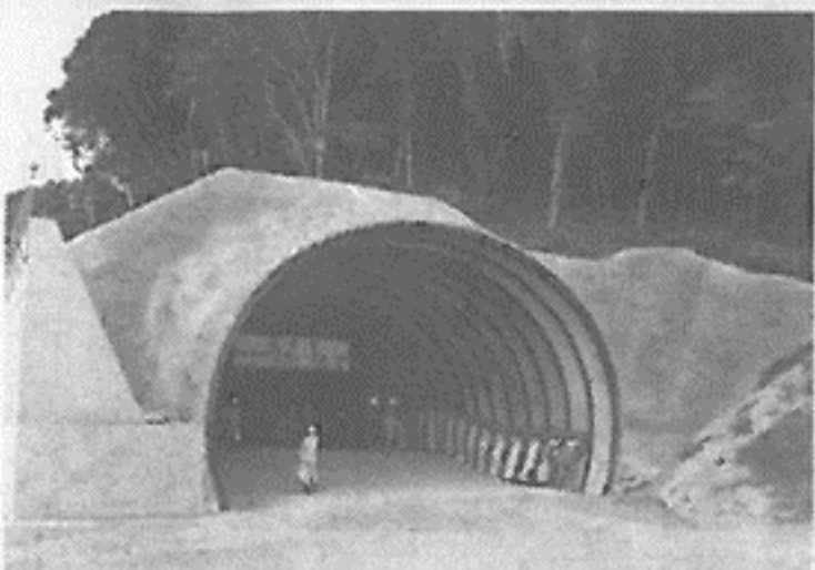
貫通側坑口部
